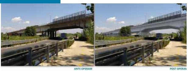
costituiscono il viadotto, dal km 0,200 al km 0,850 e prevede l'abbattimento prima della carreggiata in direzione aeroporto, spostando la viabilità in entrambe le direzioni sull'altra. E successivamente dell'altra carreggiata, in modo da non interrompere mai completamente la viabilità ma portandola da quattro a due corsie. Un intervento da 40 milioni di euro
