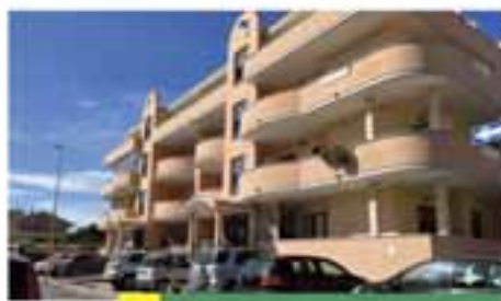
Via portico Placidiano, zona centralissima, bilocale indipendente al piano rialzato, ottima occasione per investimento, con possibilità di acquistarlo arredato; posto auto.
