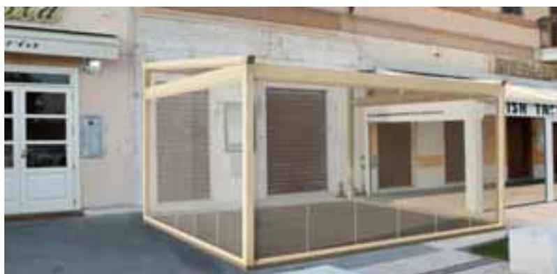
tri, di materiale metallico e color crema, seguendo lo stesso codice "Ral". La copertura superiore potrà essere a tenda, con la possibilità di rivestire le pareti con strutture trasparenti, come vetro o plastica, per garantire la visibilità. Tra le prescrizioni della Sovrintendenza c'è anche quella di realizzare le strutture su pedane rialzate di 5-10 centimetri, al fine di non rovinare la
