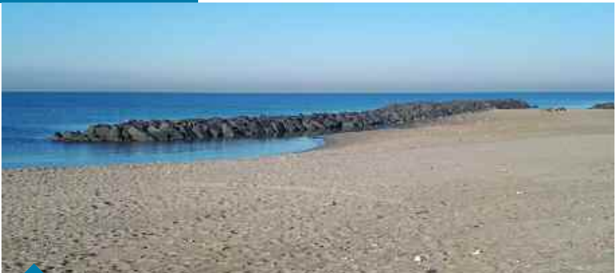
Una delle scogliere alla deriva, la prima parte è meno efficiente, l'erosione porta via la sabbia; la seconda è funzionante e mantiene l'arenile.
