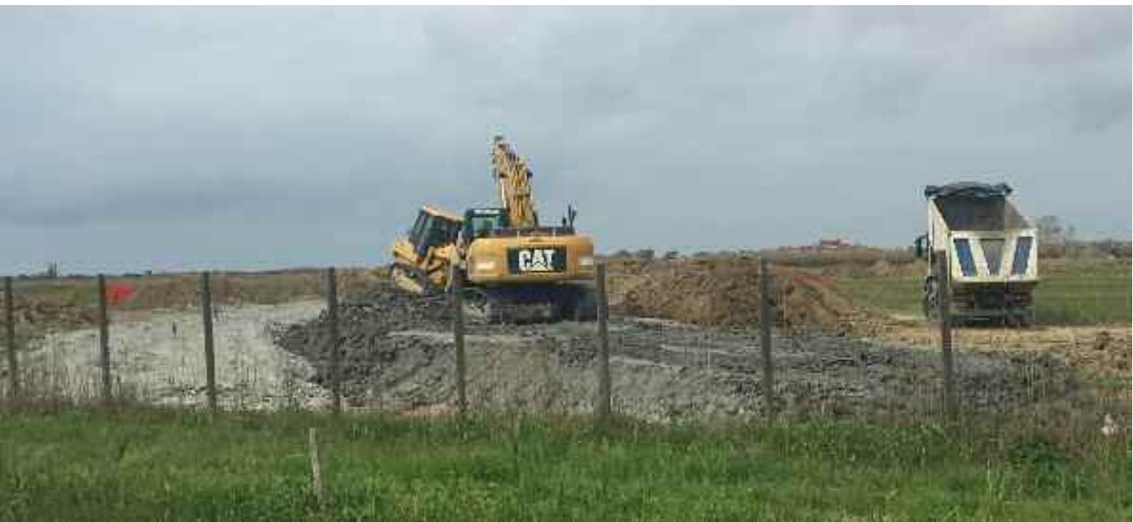
to le prime centinaia di metri di tessuto "geotessile" su cui realizzare l'argine a protezione del territorio sul quale scorre il fiume Tevere. Si tratta di un'opera lunga circa 2 chilometri e alta 3 metri, che si raccorderà con l'arginatura di Fiumara lungo via Costalunga, per terminare poi su via del
